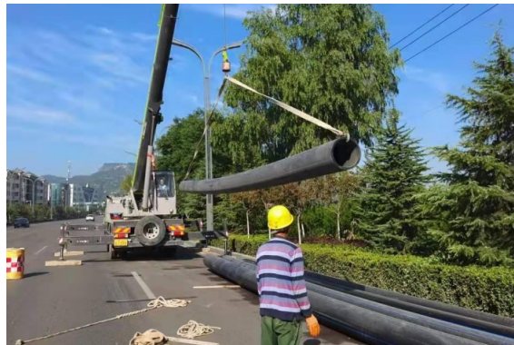
城区供水管网改造
