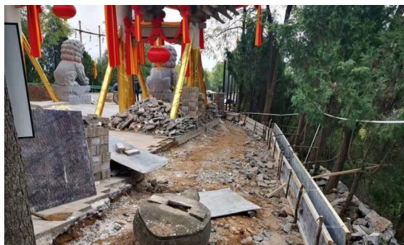
王母宫基础设施维修
