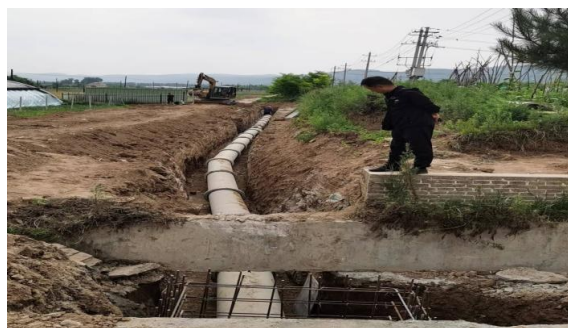
农村污水处理管道埋设
