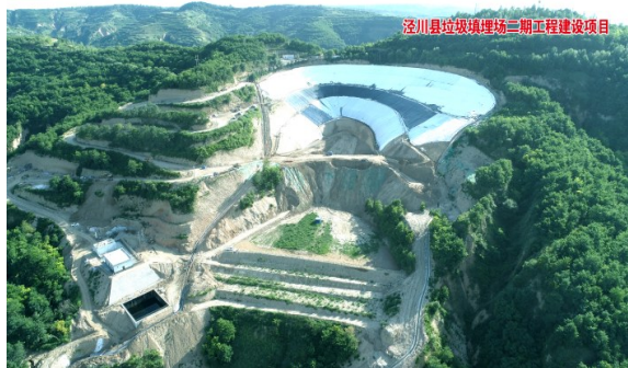
泾川县垃圾填埋场二期工程
