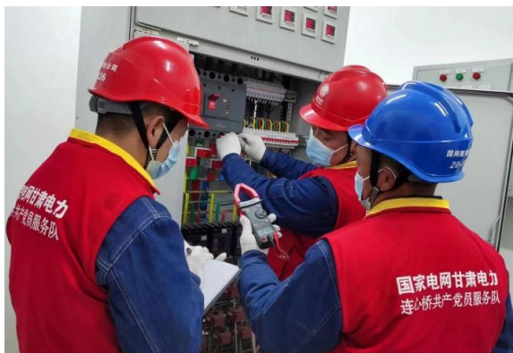
党员服务队电网维修作业
