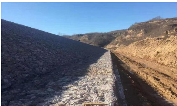
黑河河堤治理
