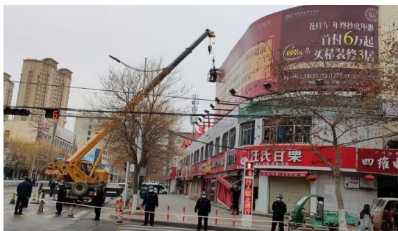
拆除户外违规大型广告牌
