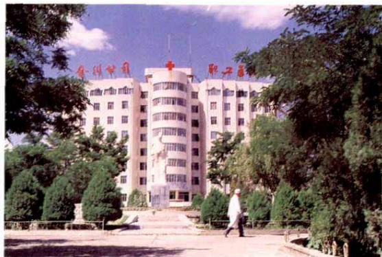
• 职工医院外科大楼。
