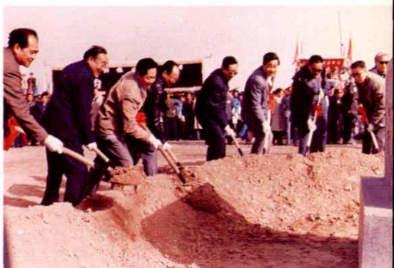
• 1988年4月24日，金川二期工程建设全面开工。
