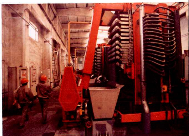
• 精矿车间自动压滤机。
