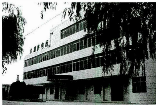
图 4-3-1 35 千伏水源供电所
