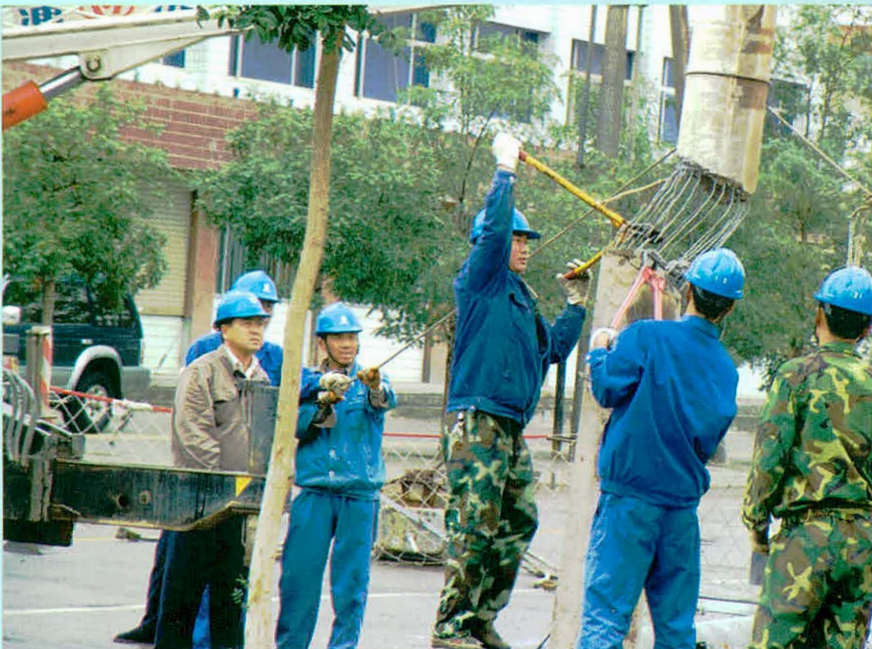
配网线路 故障抢修现场
