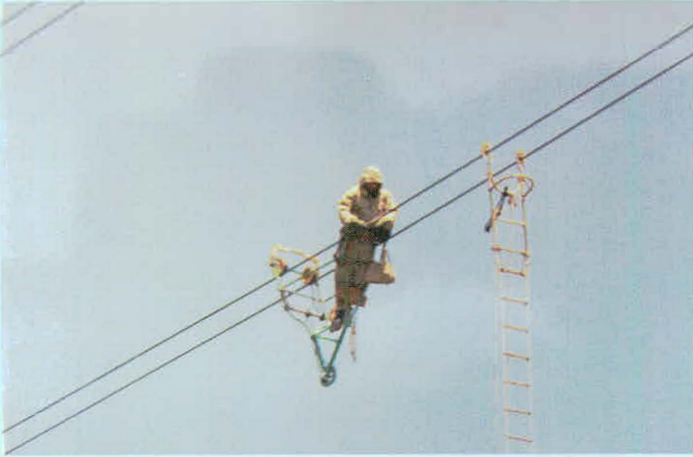
输电线路高空带电作业场景
