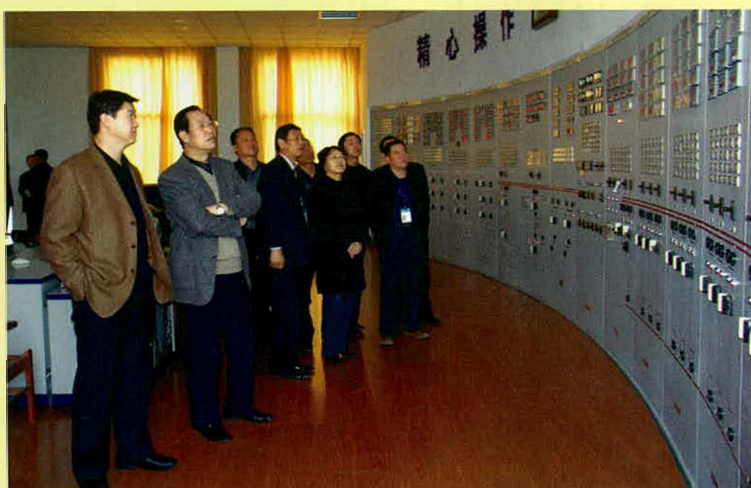
2005 年 10 月 甘肃省人 大立法委员和甘肃省电力公 司领导到 330 千伏金昌变电站 金昌变电站检查指导工作
