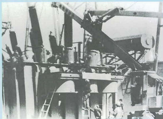
1992年5月 宁远堡变电站2号主变检修工作现场
