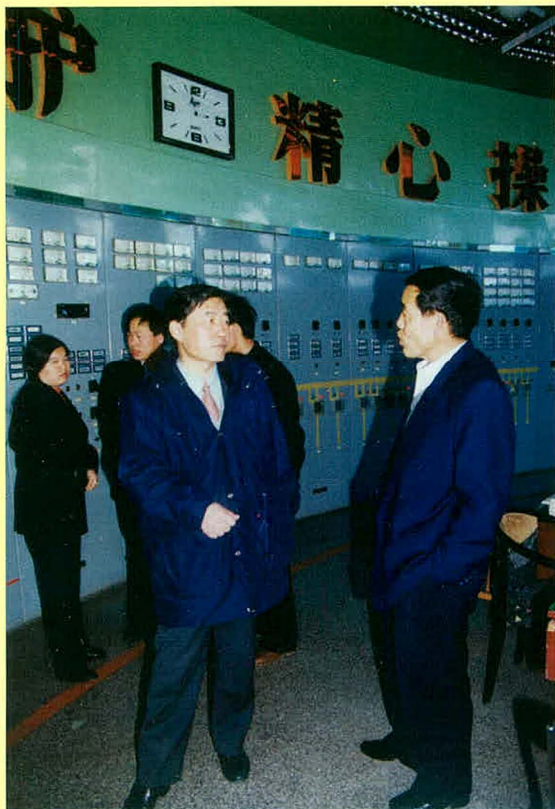
1999年9月 甘肃省电力工业局局长黄德明(右二)到220千伏宁远堡变电站检查指导工作。
