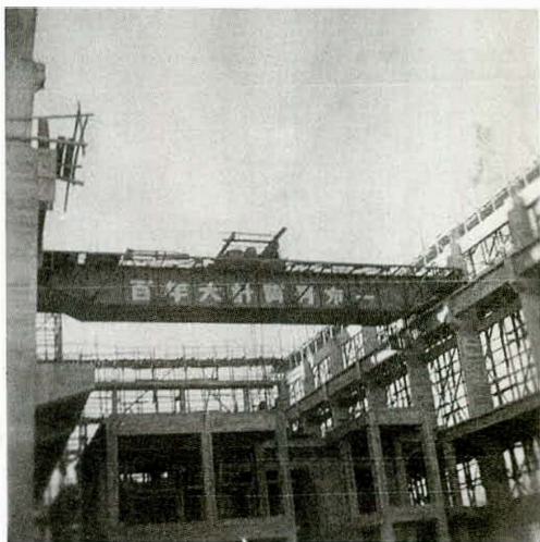
图 1-3-1 建设中的永昌电厂一、二期工程主厂房
