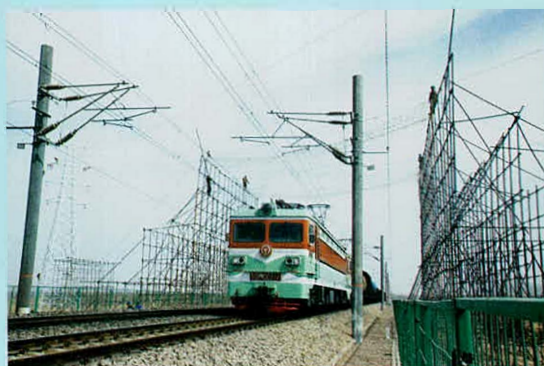
2009 年 4 月 110 千伏宗龙一、二回线 路顺利跨越兰新铁路
