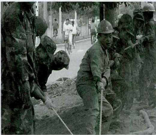
图 4-1-2 农网改造施工现场
