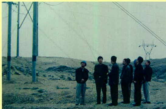
2001年9月27日 甘肃省电力公司副总经理陈晓伦(左二)检查110千伏金民线
