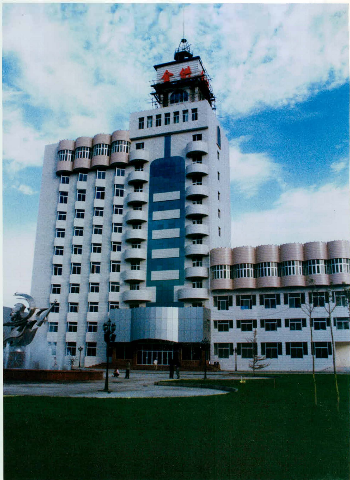
金昌供电公司河西堡办公楼
