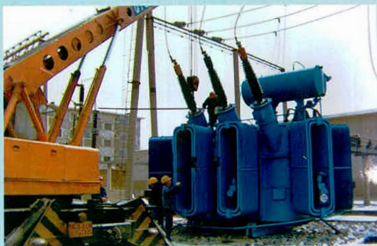
1992年3月 110千伏市政变电站施工现场
