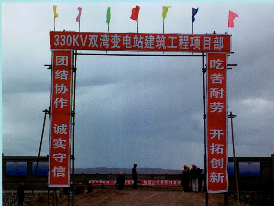
2007 年 7 月 12 日 330 千伏 双湾变电站土建 开工
