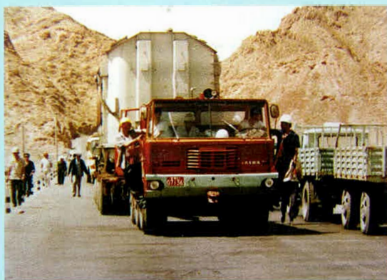
1990 年 7 月 23 日 330 千伏金昌变 2 号主变在运输中
