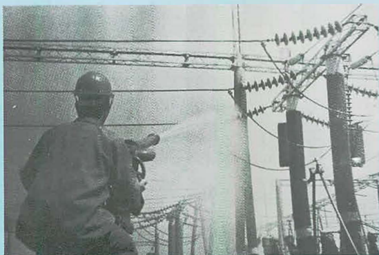
1991年9月 工作人员用水冲洗110千伏设备
