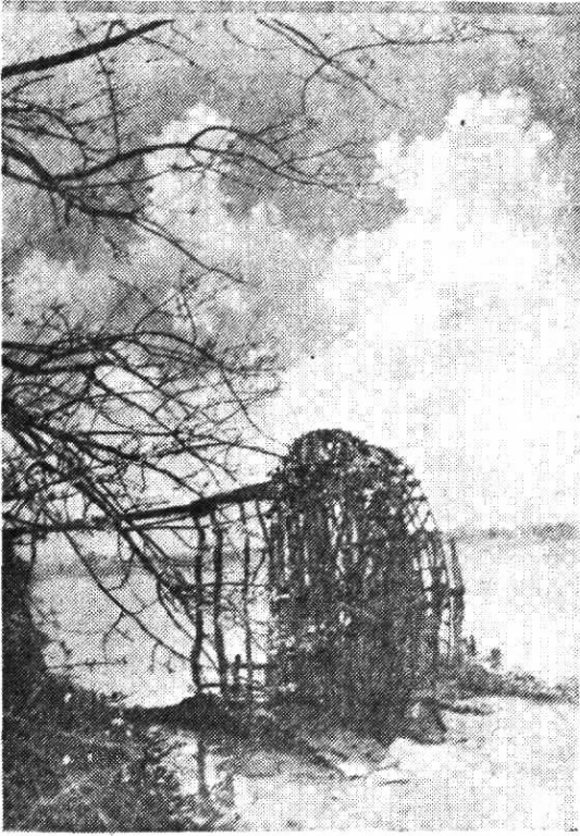
图三一1 陇中地区黄河沿岸，利用天车灌溉
