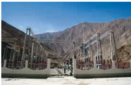
农网线路建设
