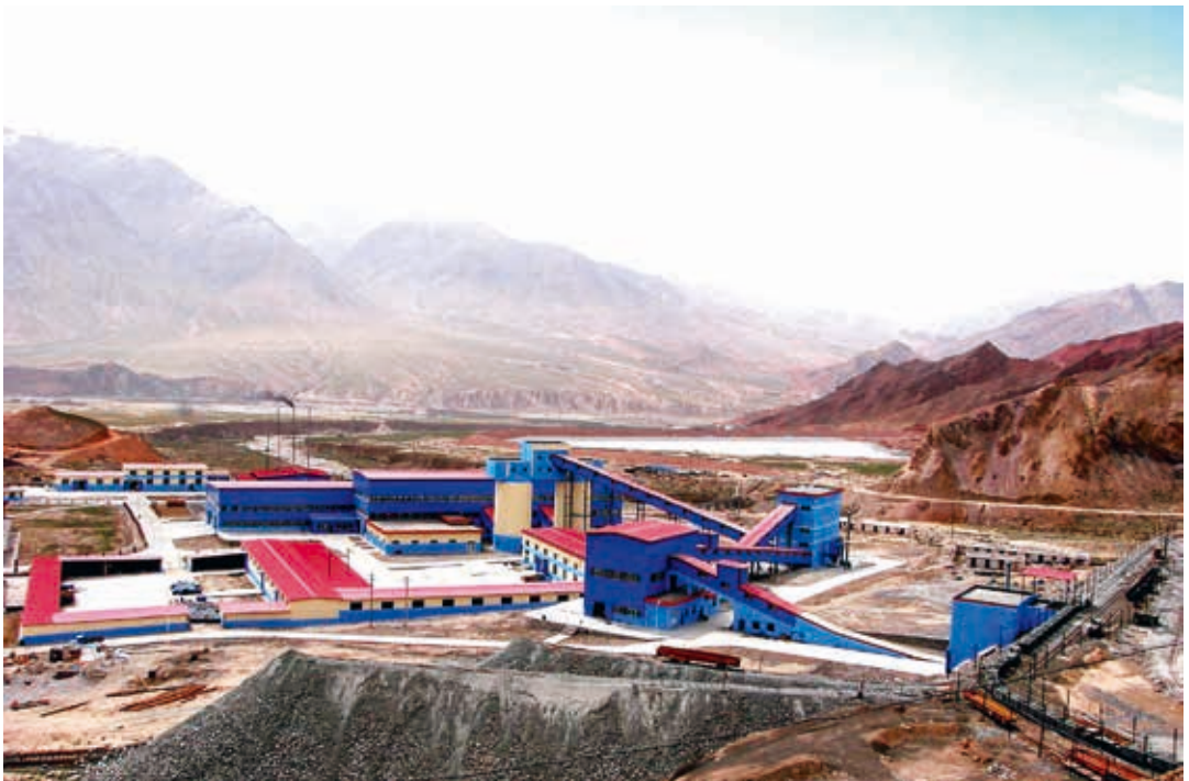
以矿产资源采选加工和水电资源开发为主的工业园区建设起始于 2003 年，重点有祁青工业园区和大河循环经济工业园区两个工业园区，入驻企业 29 户
