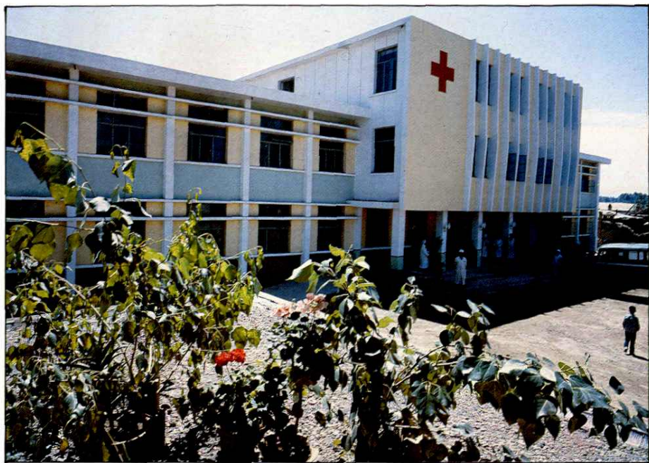
山丹医院门诊楼
