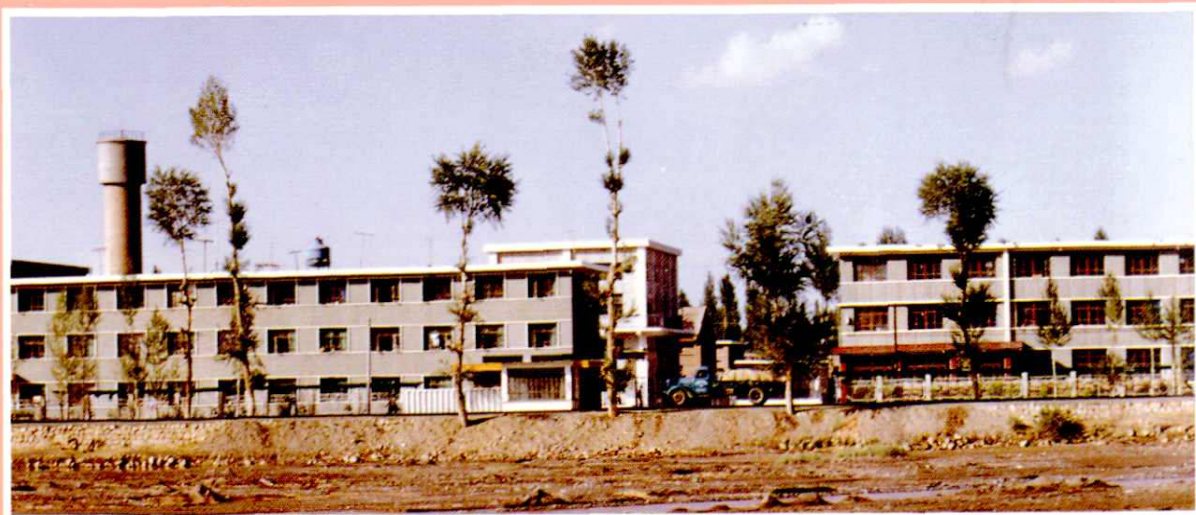
▼ 建设中的临泽淀粉厂
