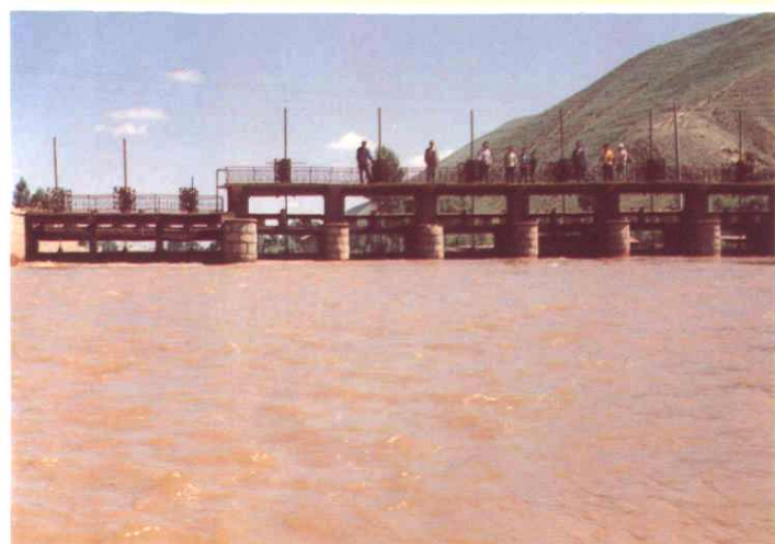
古浪河渠首工程 田国治 摄
