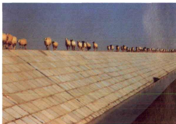
引黄总干渠一角
