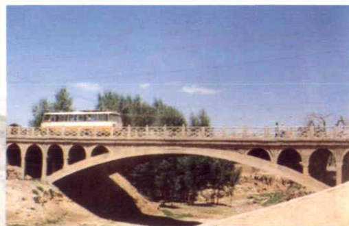
土门公路大桥 田国治 摄
