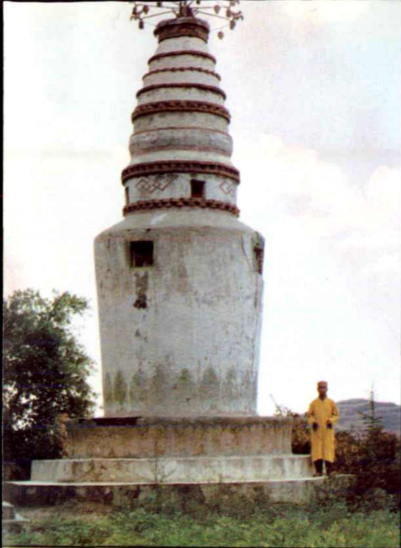
恭门老庵佛教寺观藏经塔
