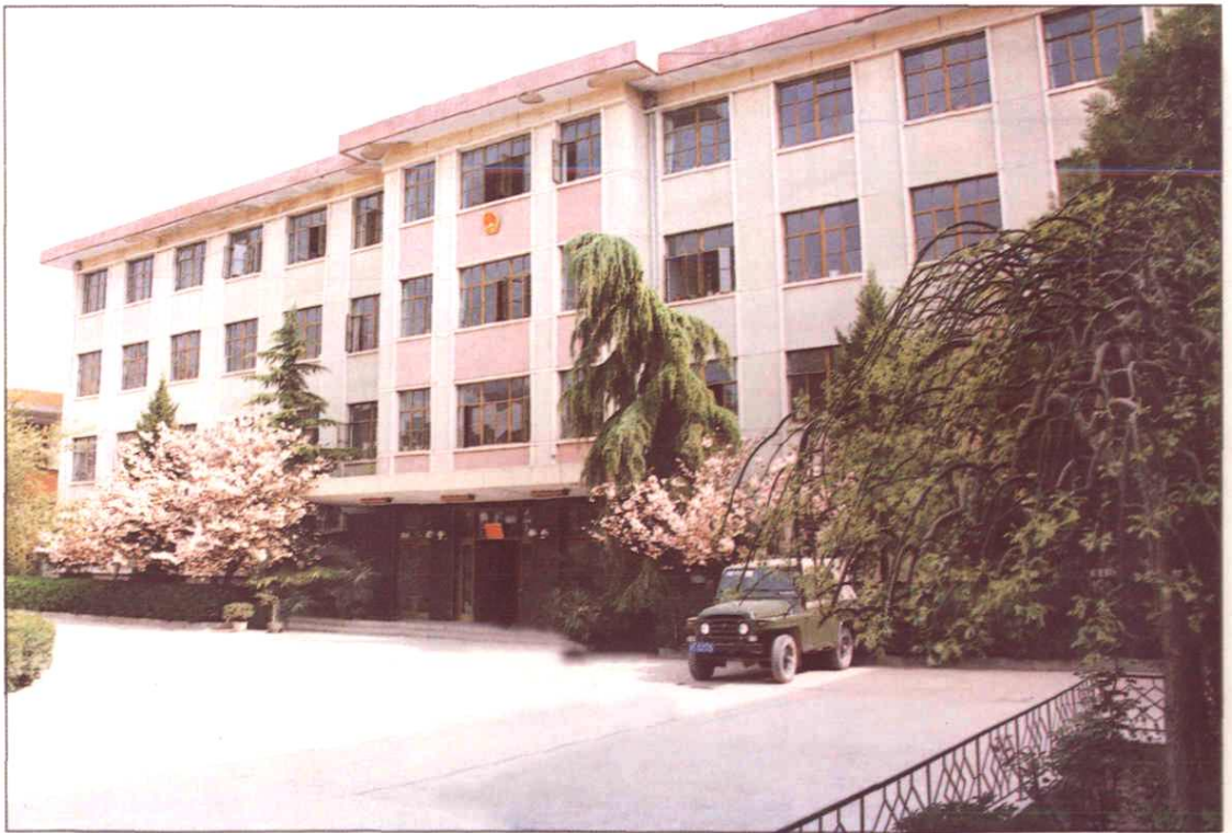
清水县人民政府办公大楼
