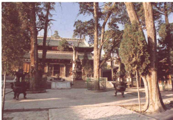
伏羲庙先天殿
