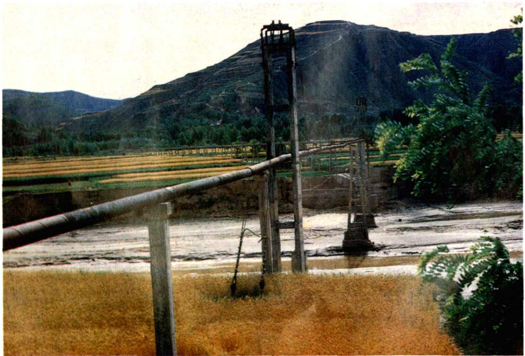
曲子刘旗跨江渡槽
