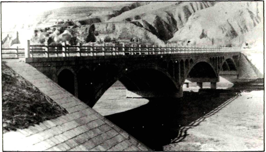
环甜公路二十里沟口大桥
