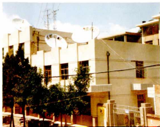
县广播电视大楼
