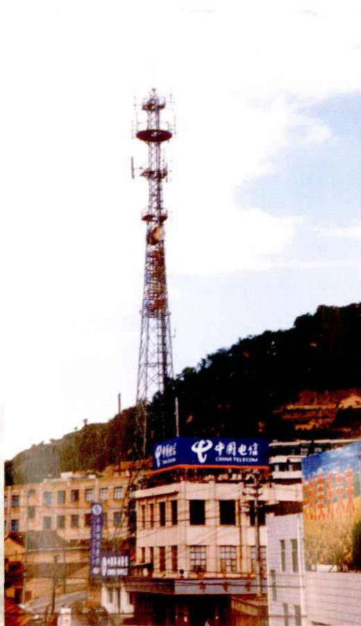
县邮政电信大楼
