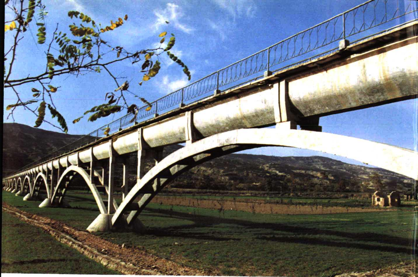
金锁灌渠渡槽
