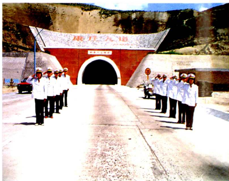
祁家大山隧道
