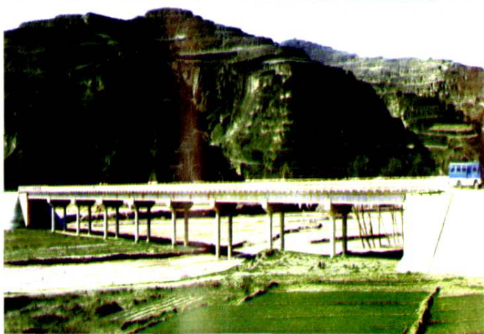
静秦公路—威戎葫芦河大桥
