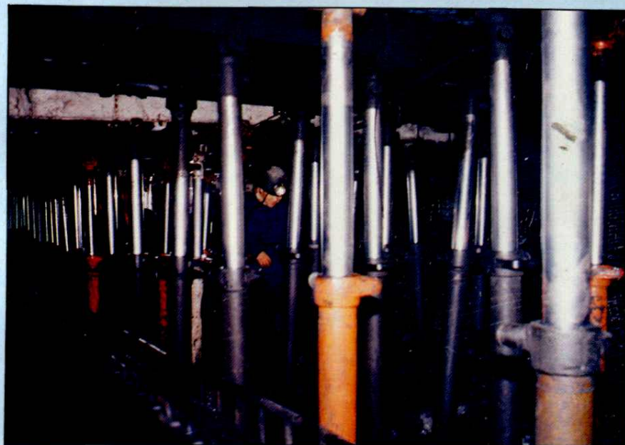
华亭煤矿井下液压支架
