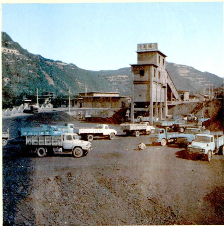
新窑煤矿选煤楼
