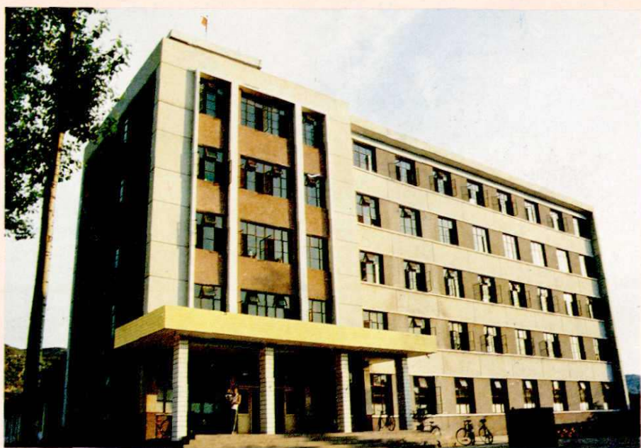
县医院住院楼
