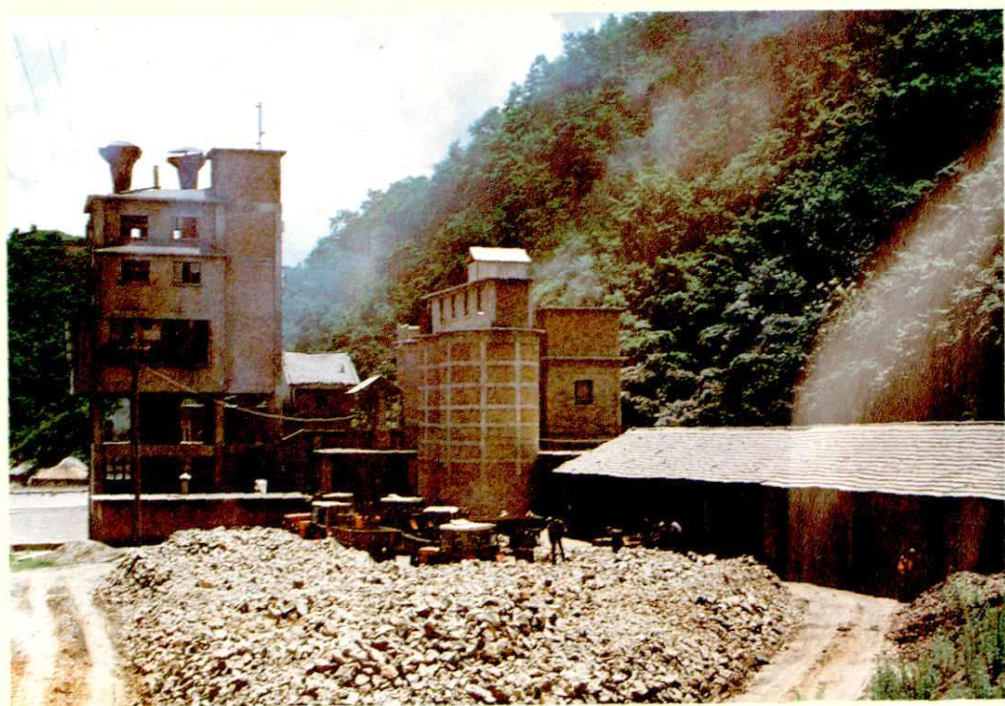
县水泥厂烧结楼
