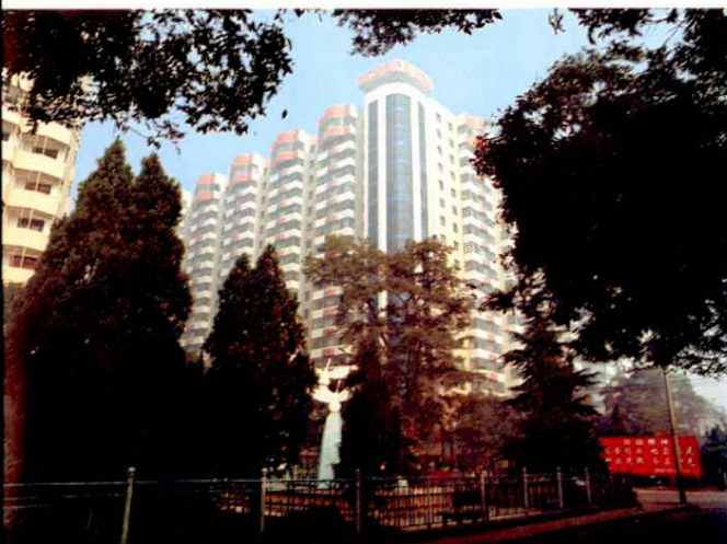
福利路兰化住宅小区
