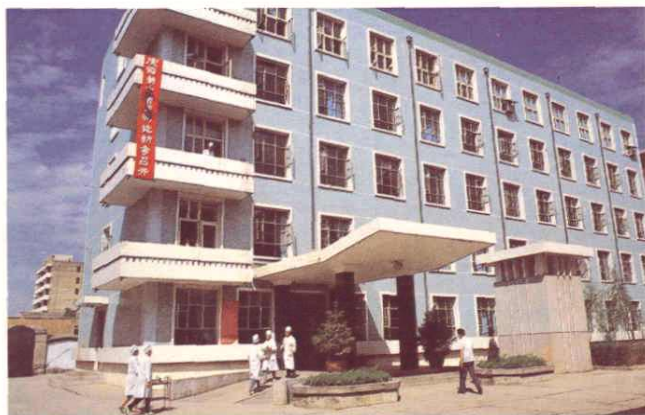
城关区人民医院住院部大楼
