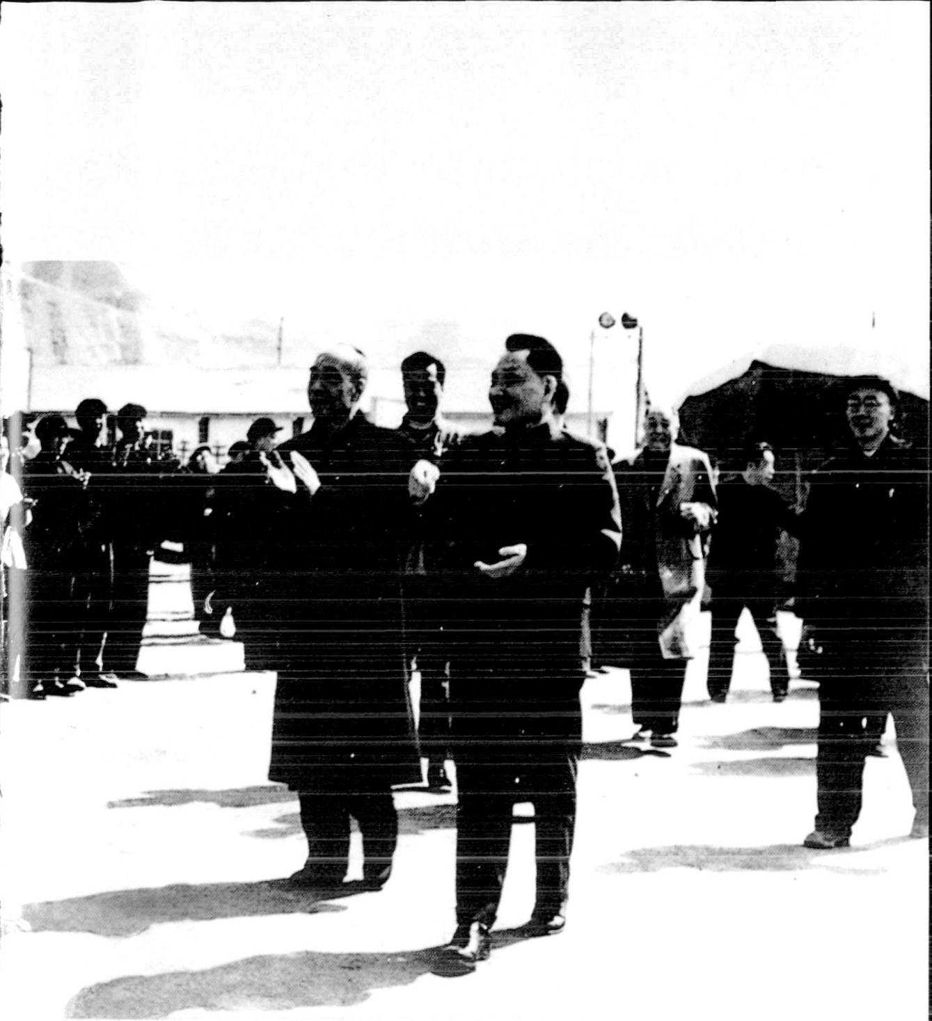
1964年国务院副总理邓小平、李富春视察刘家峡水电站建设工地
