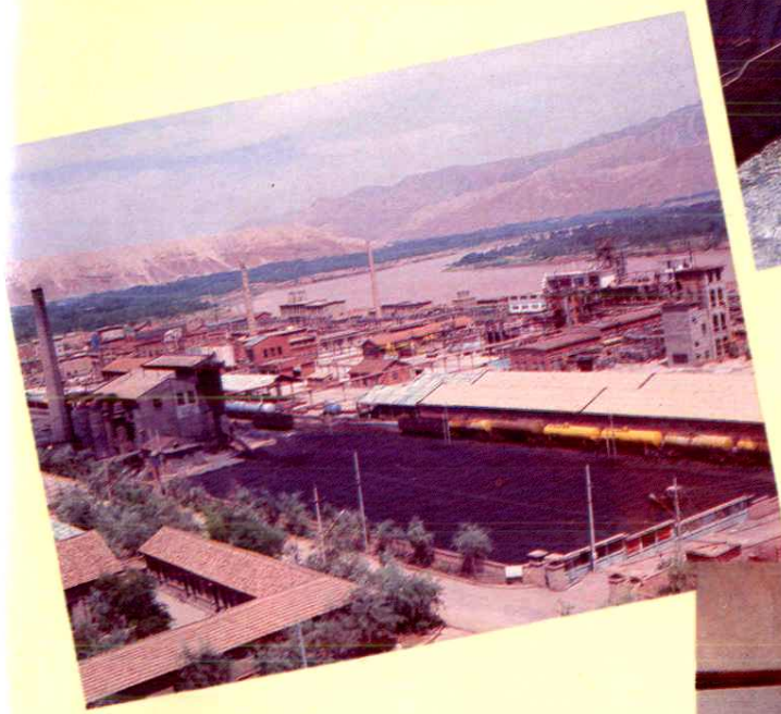
盐锅峡化工厂外景
