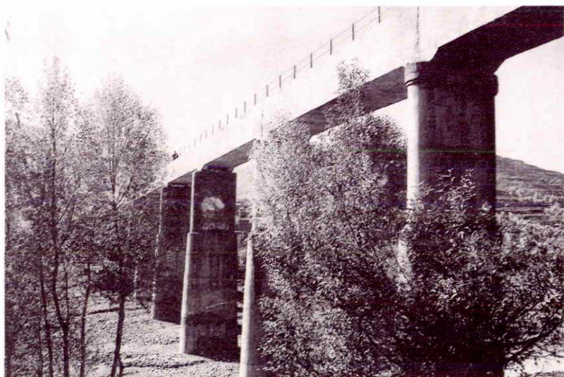
北塬渠红水沟大渡槽
