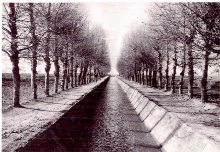
北塬渠总干渠衬砌
