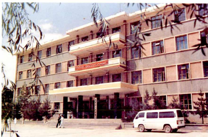
县政府办公大楼
