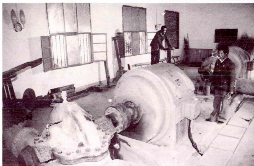
大寨子电灌站一级泵房
