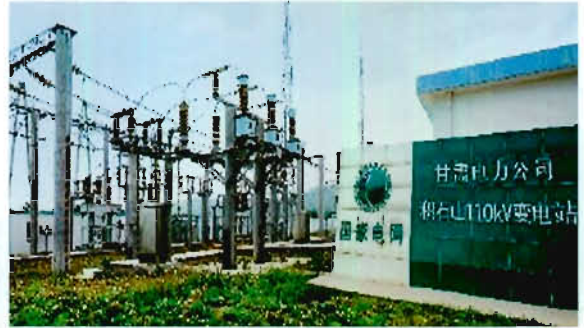
县城变电所建设
