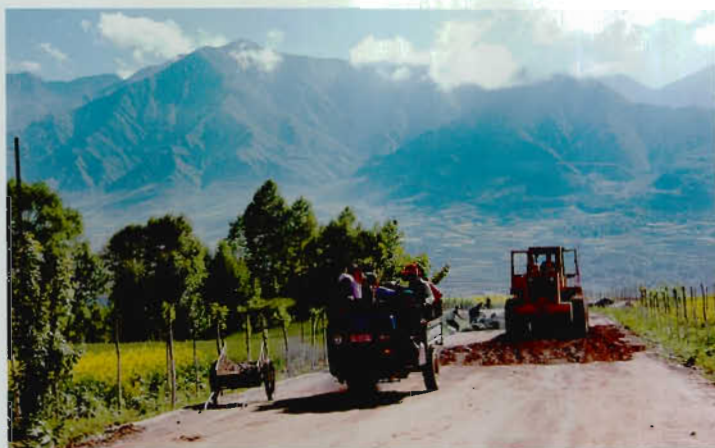
2007年临大公路建设中
