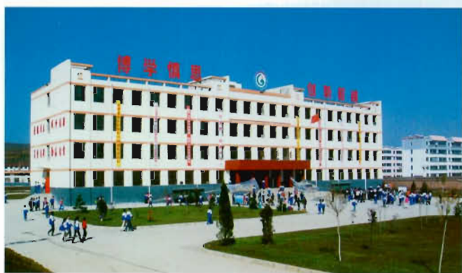
2008年10月30日竣工的 农村寄宿制项目学校——高关 初级中学
