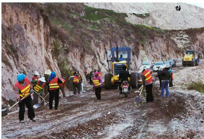
柳沟乡农村道路建设现场
