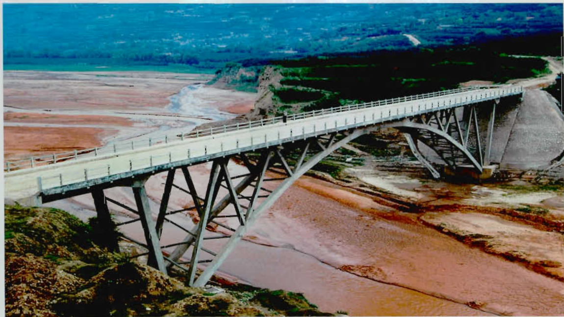
2007年建成的银川乡鸚鵡嘴大桥
