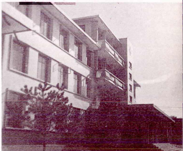
县医院门诊楼
