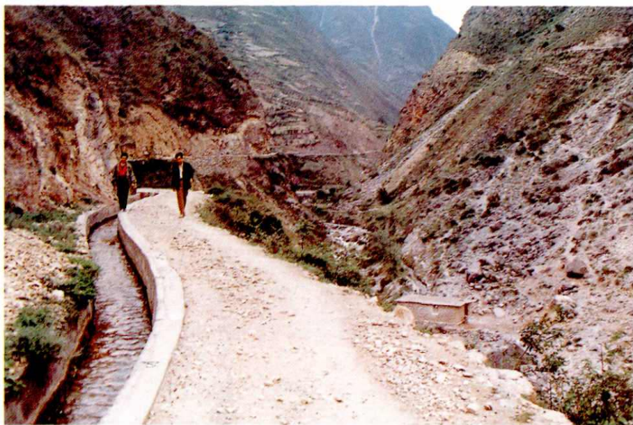
石鸡坝哈南村和平渠
