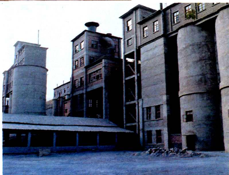
县水泥厂机房一角
