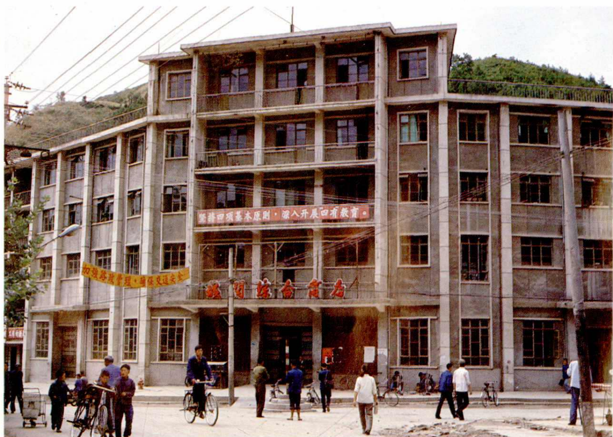
康县供销社综合大楼
