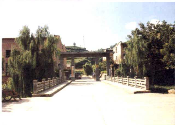
天水市洛坝铅锌矿厂部
