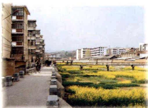
县城桥西住宅小区
