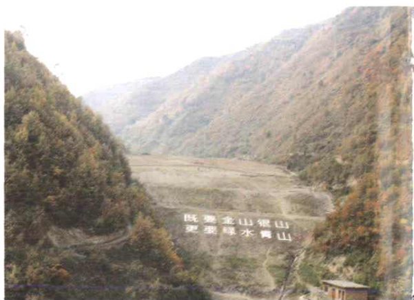
甘洛集团洛坝铅锌矿尾矿坝
