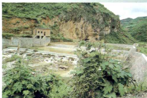
伏家镇峡门灌渠渠首
