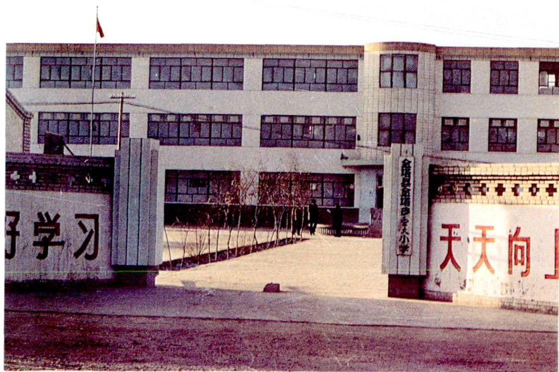
金塔乡金大村小学教学楼
