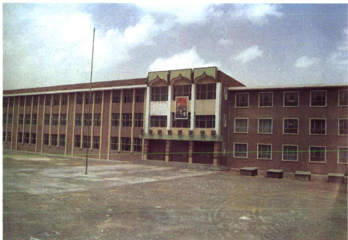
县中学教学大楼
