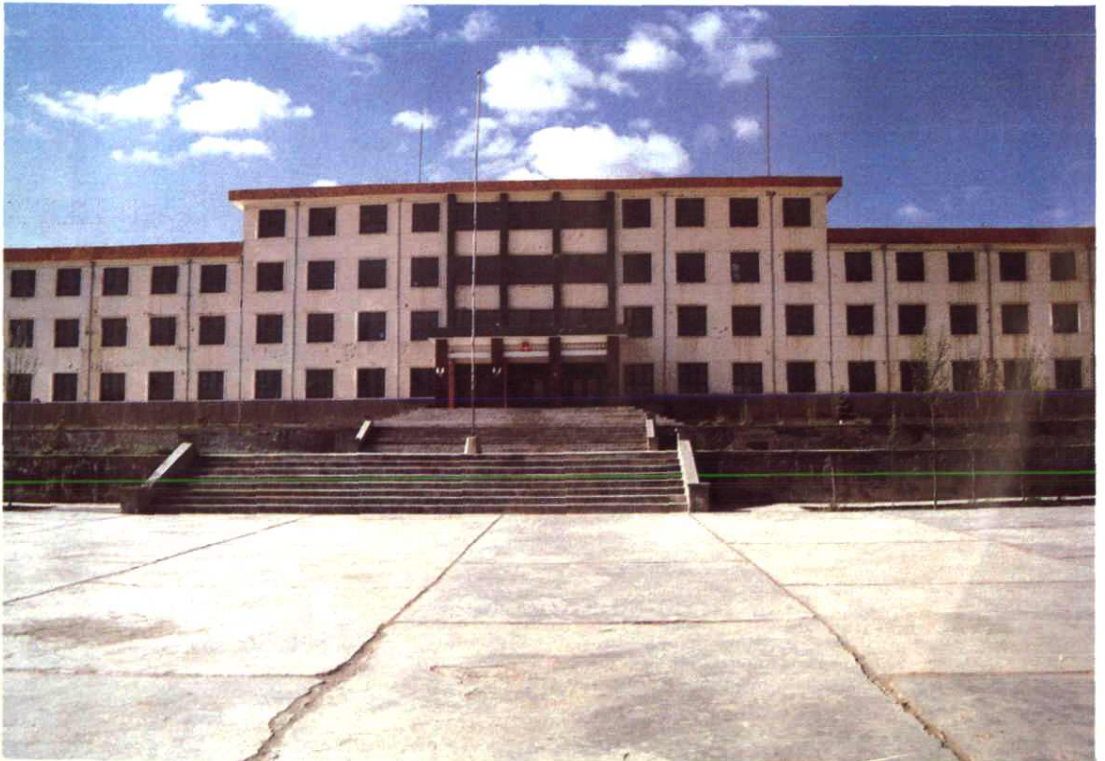
县政府办公大楼
