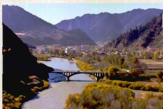
麻路洮河大桥（2010年 摄）
