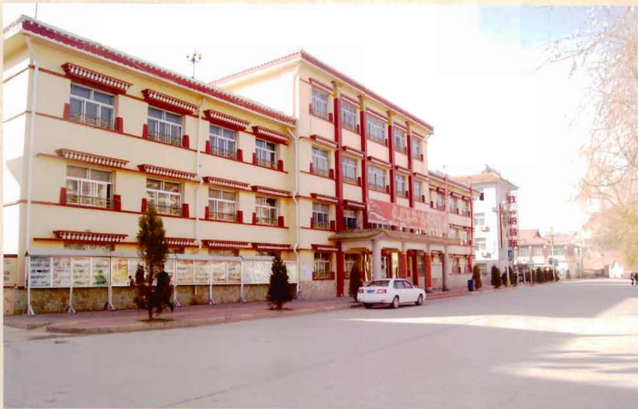
县委办公楼（2010年12月 摄）
