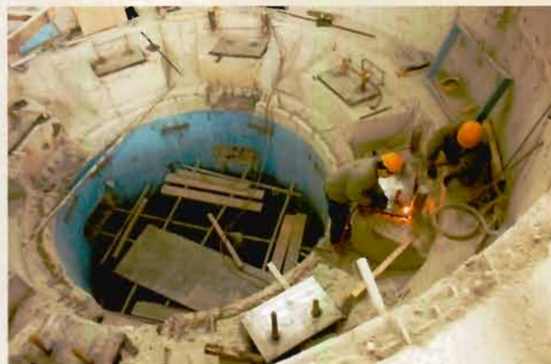
扭子水电站二号发电机组装机（2010年4月 摄）
