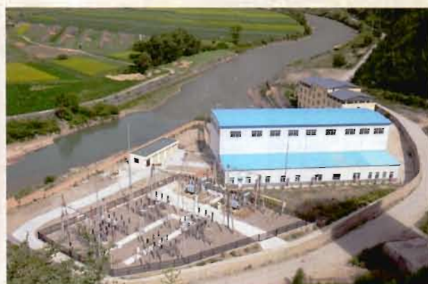
汇能水电站全景（2010年8月 摄）
