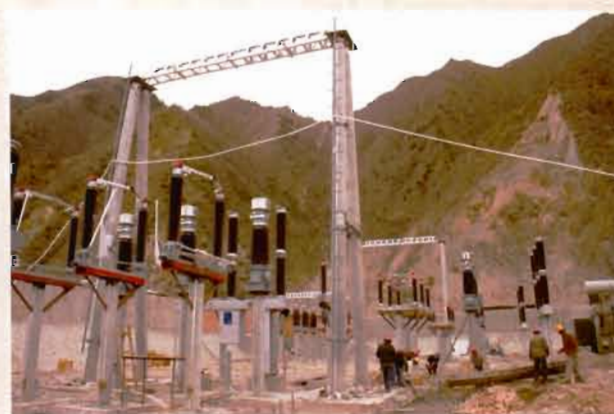
建设中的如吾水电站输变电所（2010年4月 摄）
