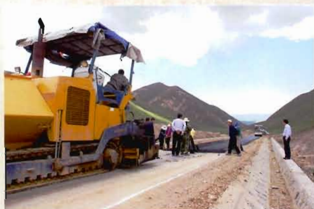
羊临路施工现场（2009年5月 摄）
