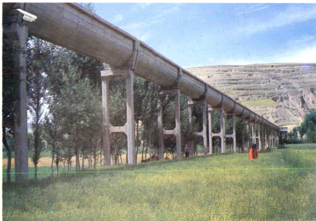
锦屏水库 干渠渡槽
