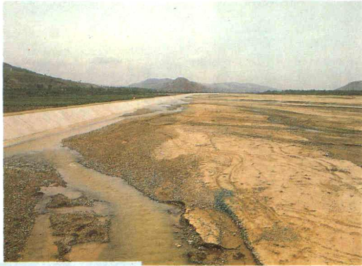
西二十里铺渭河堤防工程
