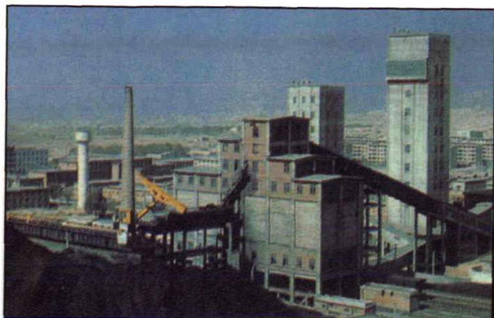
甘肃最大竖井——魏家地矿地面生产系统
