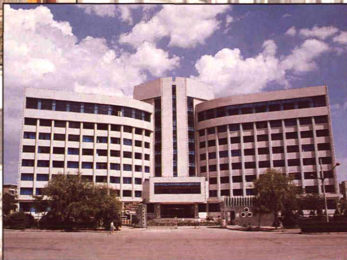
靖远电厂综合办公楼
