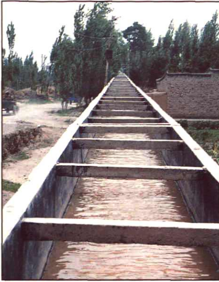
旱平川电灌工程渡槽
