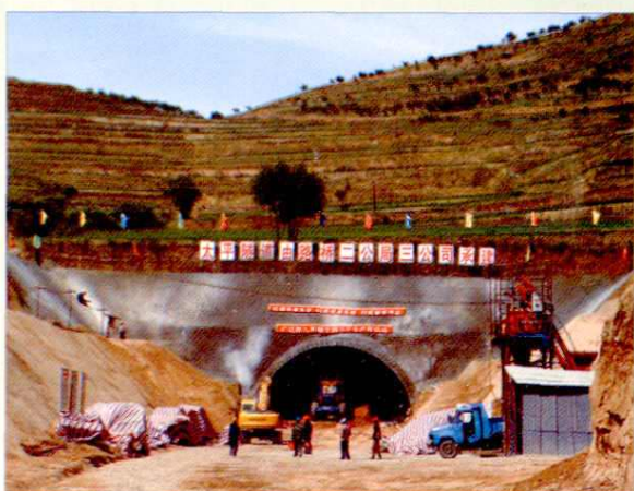
平定高速公路隧道建设
