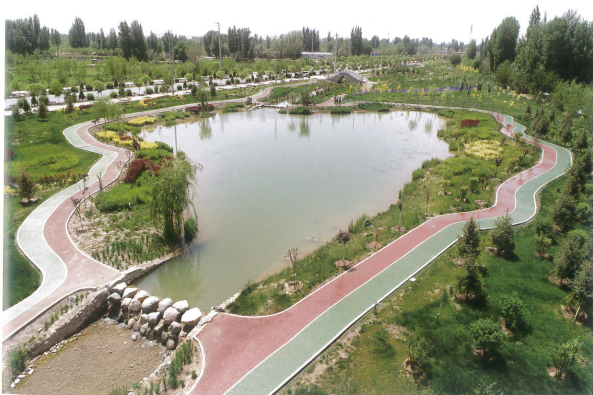
临泽县河湖连通工程
