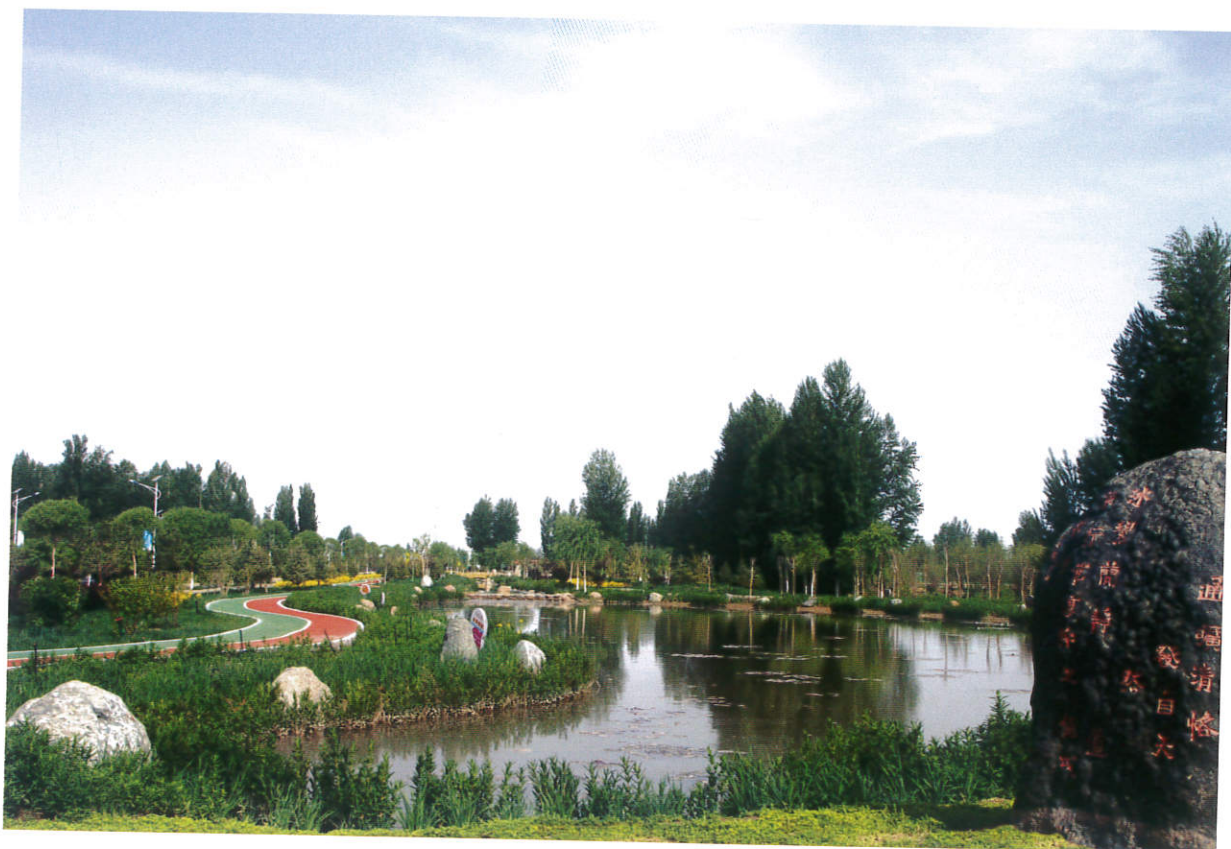
流沙河至双泉湖湿地河湖水系连通工程——沙河镇东寨村段
