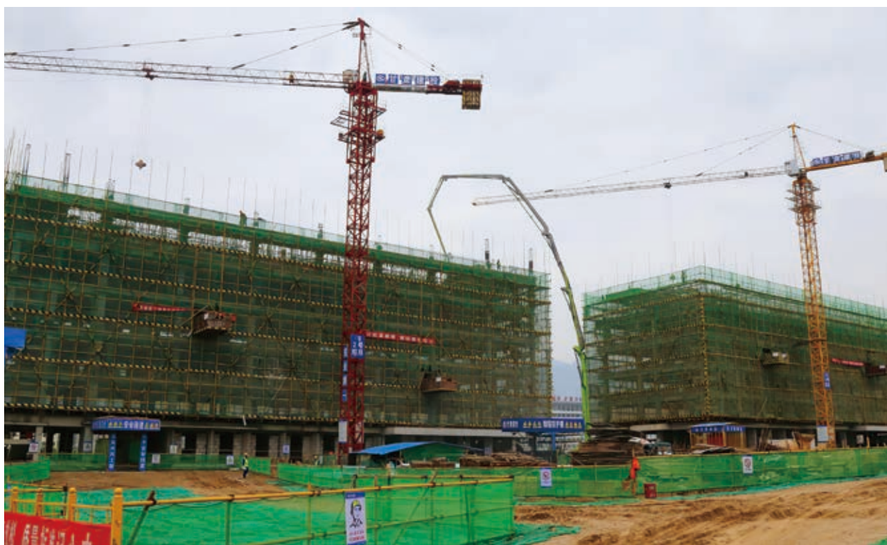
△ 武山一中迁建项目正在施工中
