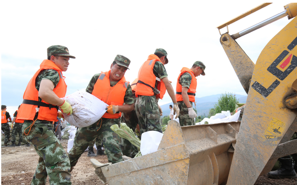
2018年7月4日武警甘肃总队天水支队抢修孟家庄段堤防
