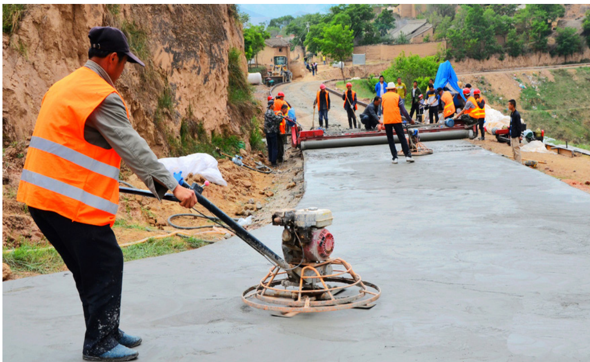
硬化乡村道路
