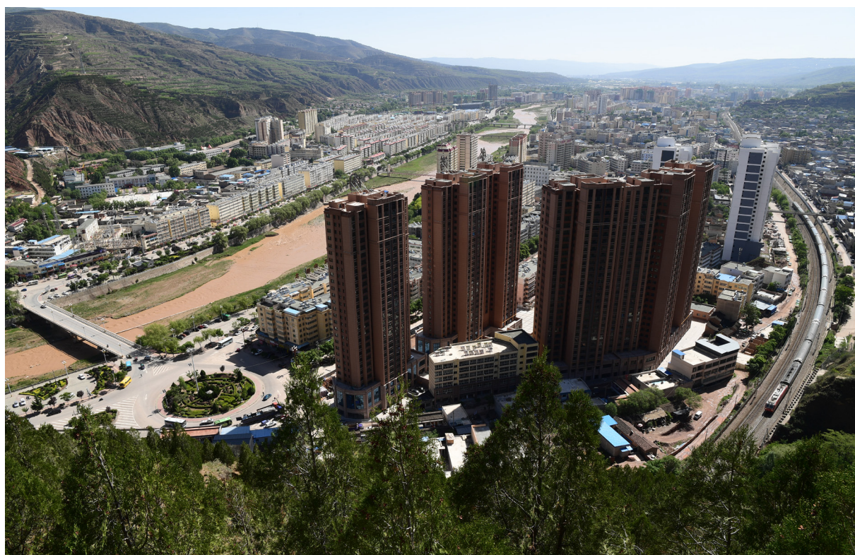
县城西关棚户区改造工程
