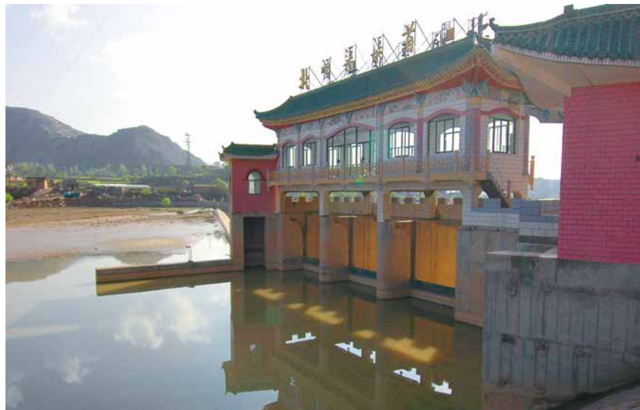
△ 渭河北顺渠进水口
