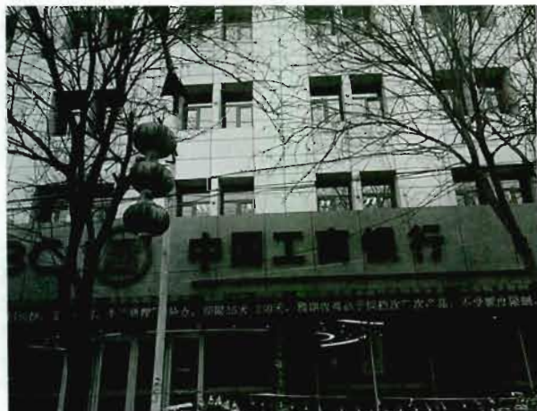
县工行新建办公大楼
