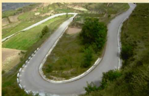
乡村公路通畅工程
