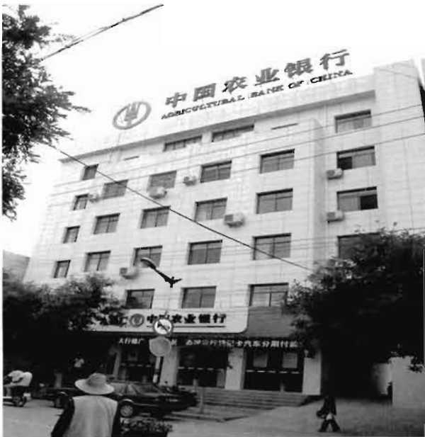
新改造的机关办公楼及营业室
