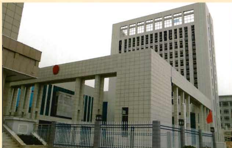
12 月,县法院办公大楼竣工
