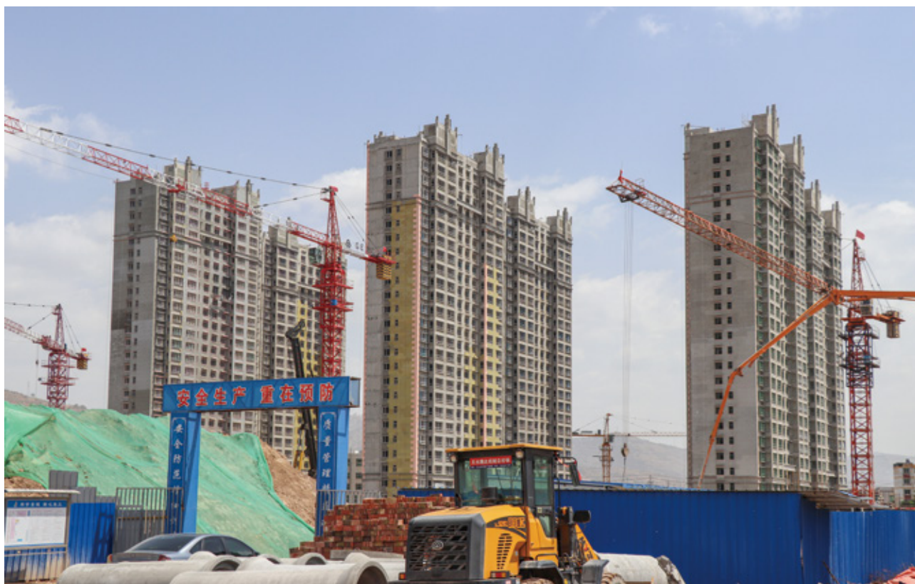
▲ 福泽华庭项目建设现场
