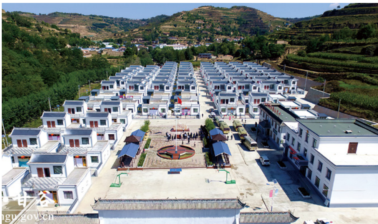
▲ 大庄镇大庄村富康新村异地扶贫搬迁安置点
