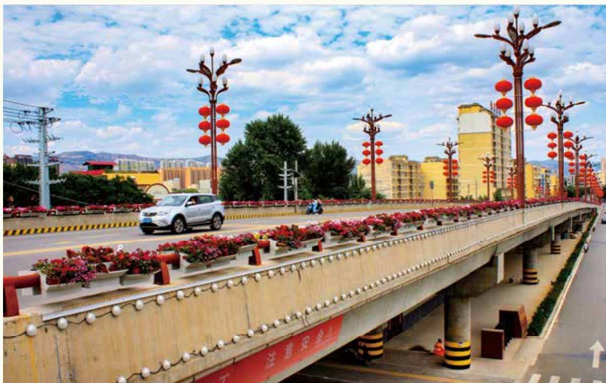
甘谷康庄路沙沟大桥
