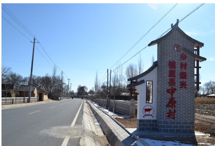
中原乡中原村乡村振兴示范村建设
