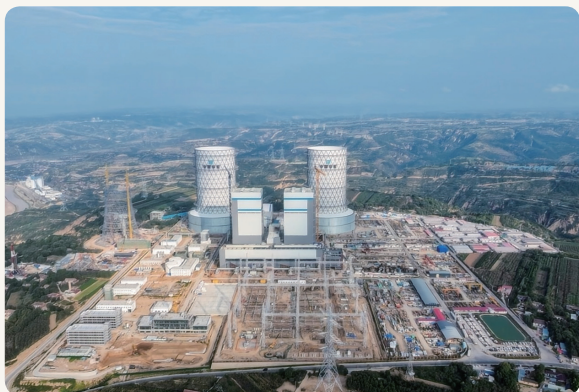
华能正宁 2 × 1000 兆瓦调峰煤电建设项目现场
