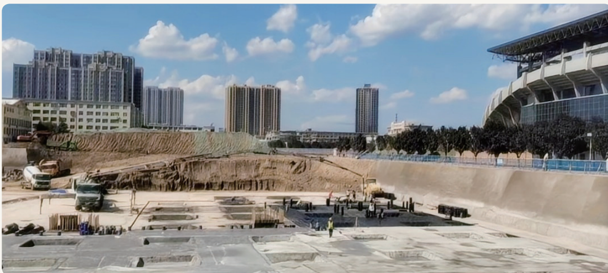
正宁县智能化立体停车场三期建设项目现场
