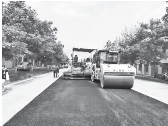
7月，农村公路养护维修工程五顷塬街道段施工现场
