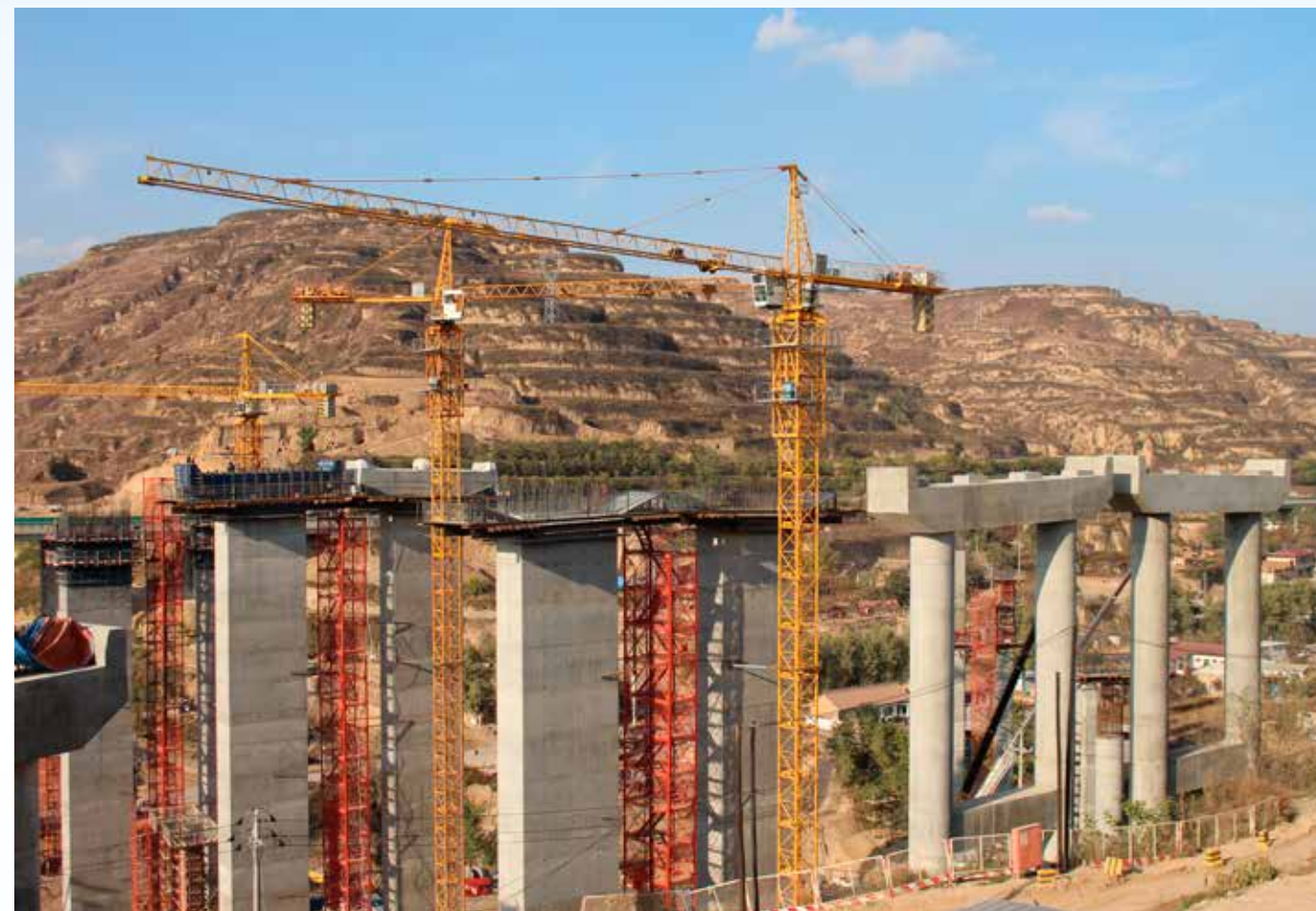
建设中甜永高速庆城镇段
