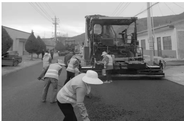
温台街道路面养护
