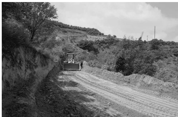
贫困户入户道路维修
