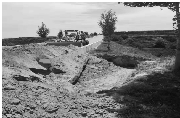
刘家畔村悦阜路维修
