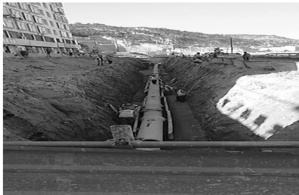
华池县集中供热一级管网延伸
