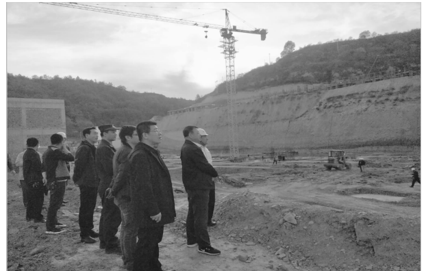
检查山水国际建筑工地
