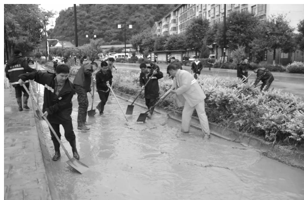
芙蓉帝庭小区南头路段应急抢险
