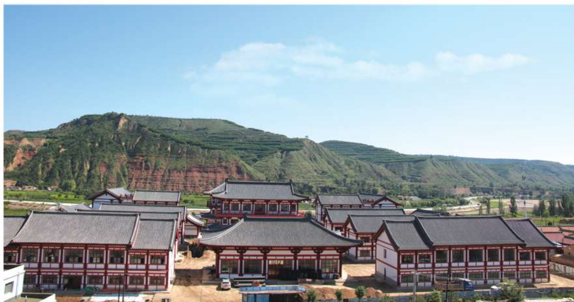
正在建设的崇信县老年养护院
