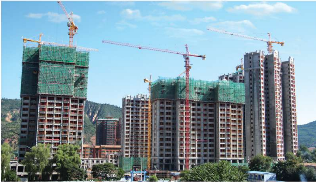
正在建设的崇信县世纪花园C区
