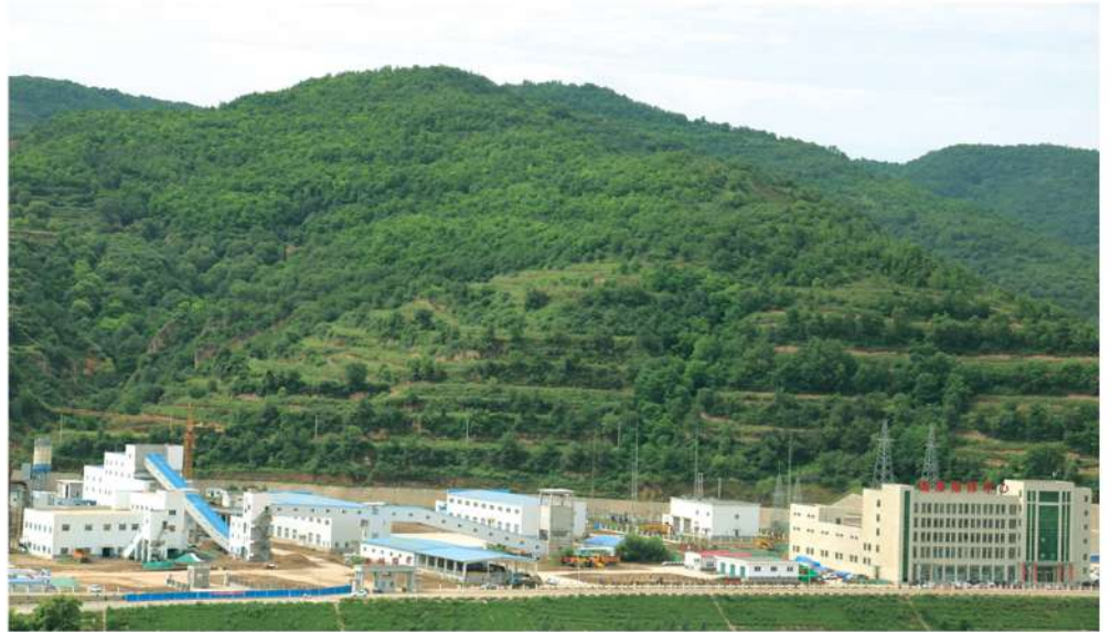
赤城煤矿矿区
