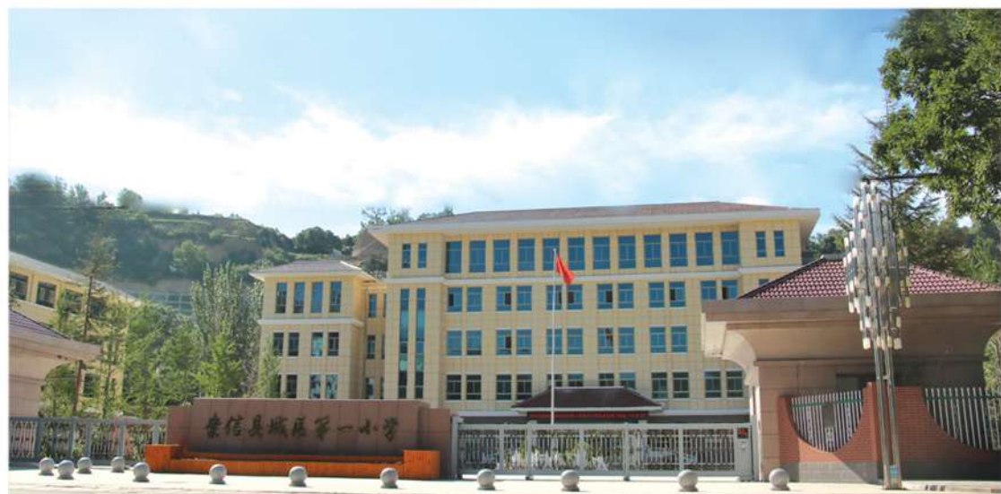
新建的崇信县城区第一小学
