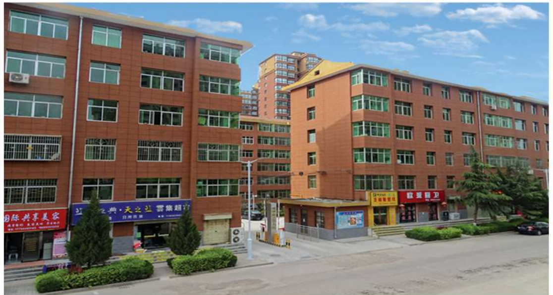
滨河路住宅小区老旧楼棚户区改造
