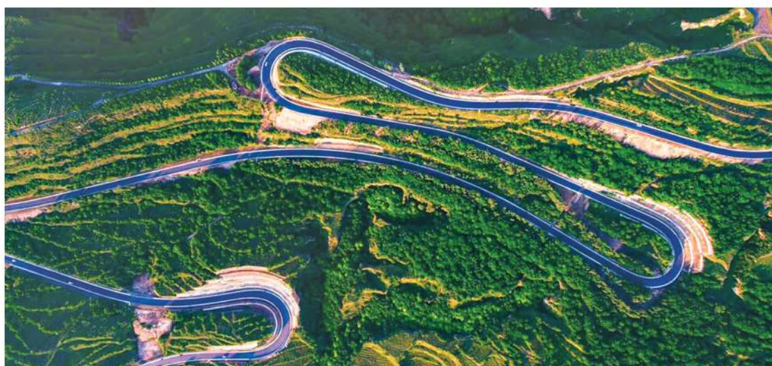
省道 S203 线崇信段改造工程
