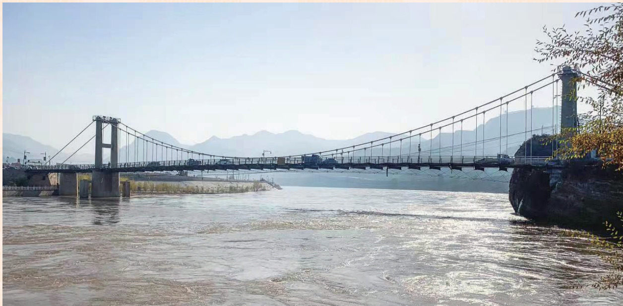
中国农民第一桥——什川黄河吊桥
