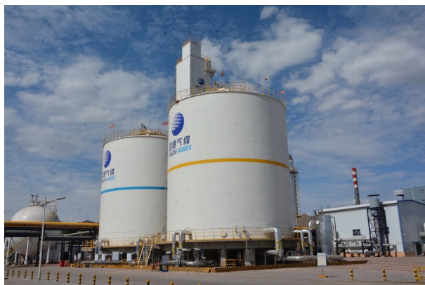
兰州盈德气体有限公司空分扩建项目
