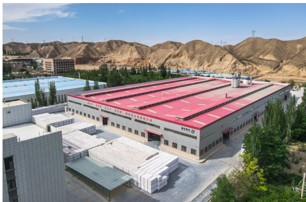
德安建材公司厂房
