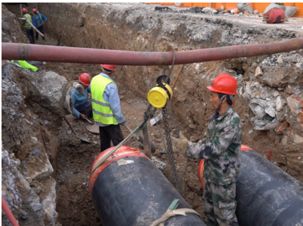
道路管道施工
