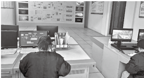
污水处理厂日常生产监测
