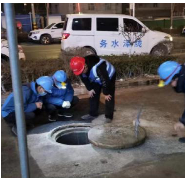
维修人员巡查供水设施
