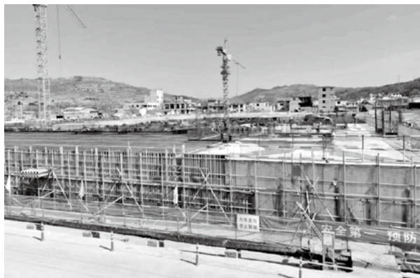
县医院整体搬迁项目建设
