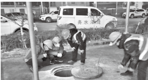
维修人员巡查供水设施
