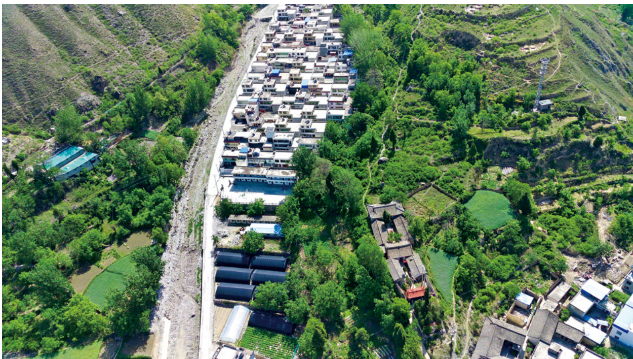
石鸡坝镇石鸡坝村水磨沟段“8·12”暴洪泥石流灾后重建河堤 摄影 / 刘爱忠
