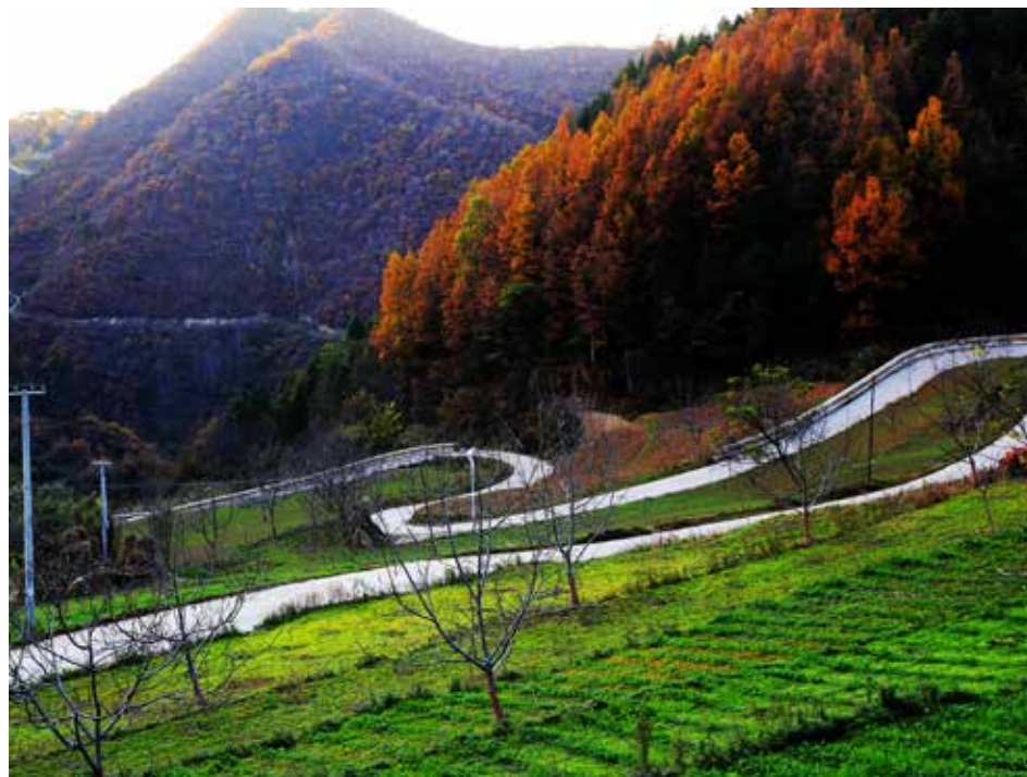
全县通村道路全覆盖
